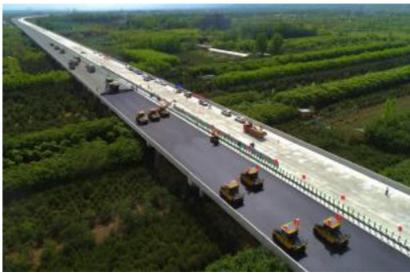
近日天气晴好，在西安外环高速公路南段路面摊铺现场，钢轮碾压机、胶轮碾压机等作业交替进行，碾压后的路面平整光亮，驾驶室却空无一人……这是陕西路桥集团沥青路面无人化施工现场，技术人员正在通过操作界面控制现场9台设备的运行。项目经理张高科介绍说：“这些设备按照设定参数施工，避免了传统人工操作中的漏压、过压或者超速现象，而且施工安全，能实现24小时不停机作业。”
