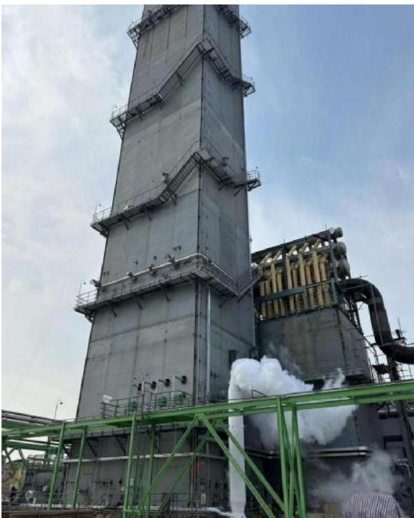
本报讯 3月31日,杭安公司空分工程分公司承接的河北太行钢铁集团重组搬迁改造项目二期制氧空分装置项目顺利出氧,氧纯度达 99.97%,产量 50080Nm<sup>3</sup>/h;氮纯度达 0.6ppm,产量 128461Nm<sup>3</sup>/h,产量、纯度均合格。
